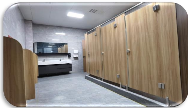
修缮办公楼墙体和卫生间
